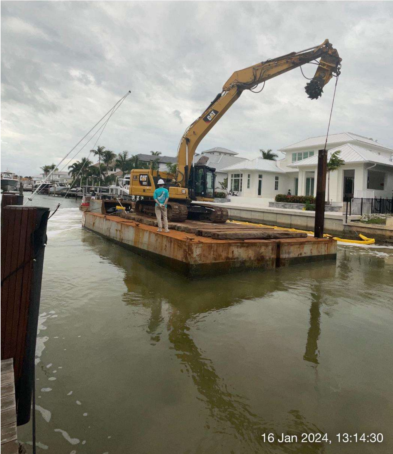
Contractor exiting Canal A-A.
