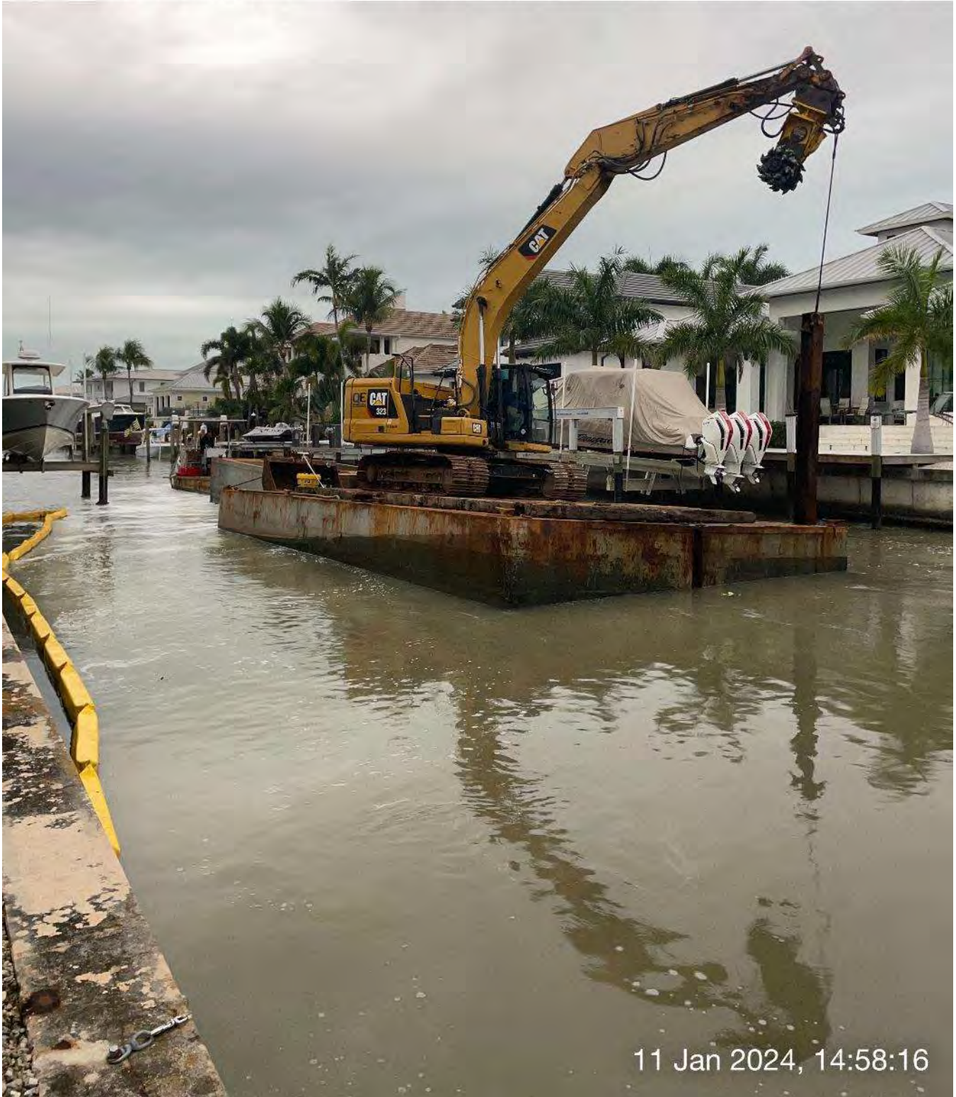
Contractor exiting Canal A-A.
