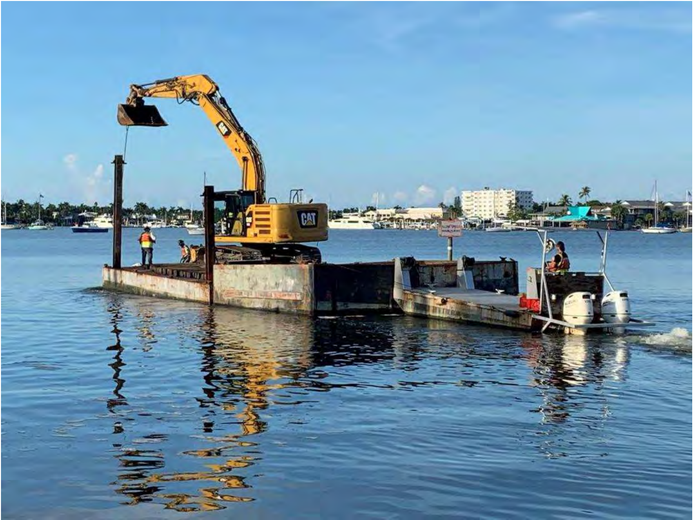
Contractor en route to Canal AA-AA.
